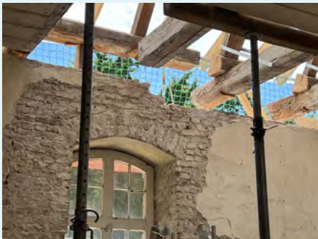
Südwand mit geöffnetem Dach
